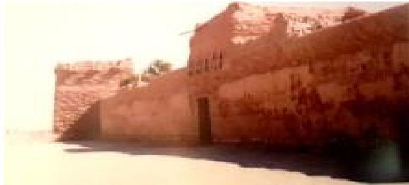
الواجهة الشمالية للقصر و يظهر المدخل الرئيسي ( لوحة : ٣٤) ( المصدر : منشورات وكالة الآثار و المتاحف - مشروع توثيق و تسجيل قصر الملك عبدالعزيز فالدوادمي )
